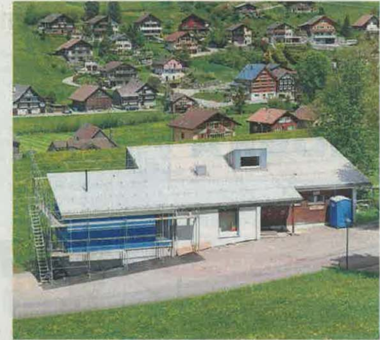
Derzeit bekommt die Skihütte erneut einen Anbau.
